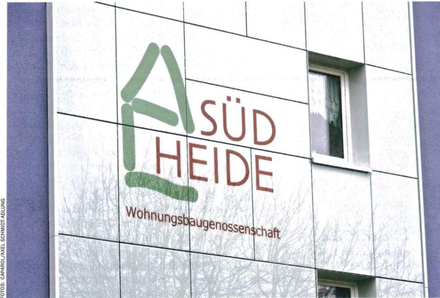
Auf der vorgehängten hinterlüfteten Fassade mit farblich beschichteten Glasscheiben ist das Logo der Genossenschaft im Digitaldruck aufgebracht. Das Markenzeichen ist von hinten beleuchtet.
